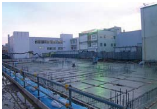
1 階床コンクリート打設完了
